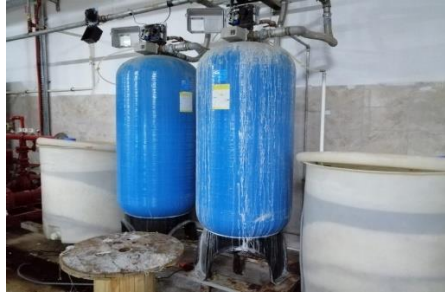
Resim 15. Su yumuşatma cihazı (iyon değıştirici)
