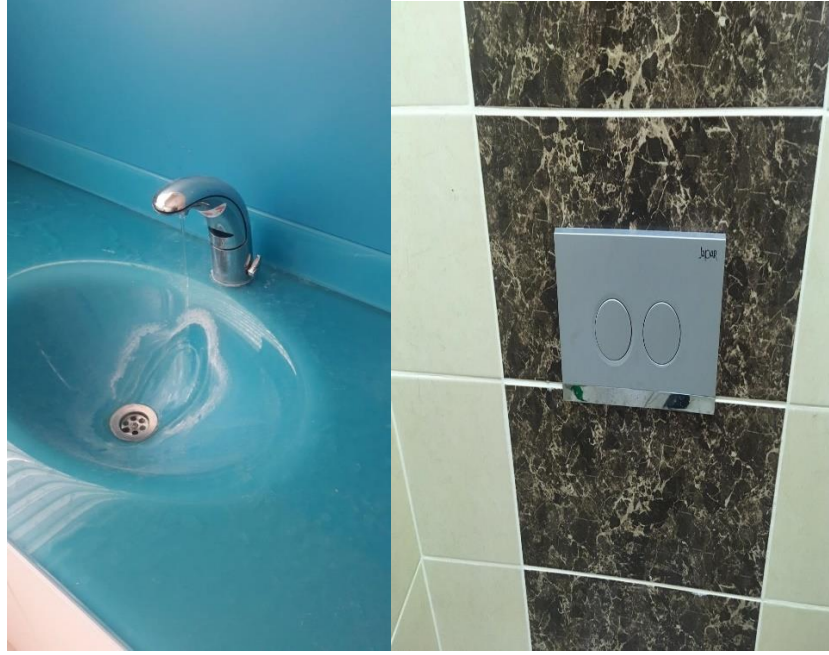
Resim 39. Su tasarrufu programı uygulamaları: fotoselli musluk ve gömme rezervuar
