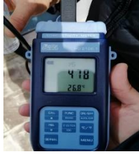
Resim 16. Isı merkezi besi suyu iletkenlik değeri
