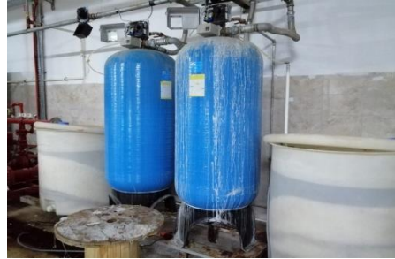
Resim 15. Su yumuşatma cihazı (iyon değıştirici)
